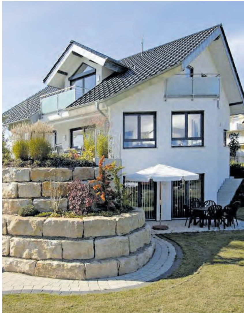
Die Bauherren dieses großzügigen Vier-Giebel-Hauses in Baden-Württemberg setzten auf Ziegel als Wandbaustoff. Auffallend sind neben den Gauen die spitzwinkligen Erker. Sie schaffen im Inneren belichtete Bereiche.
